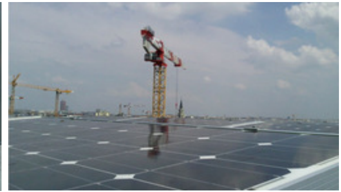
Panneaux PV à Lyon Confluence avec la solution "Accusine" testée
