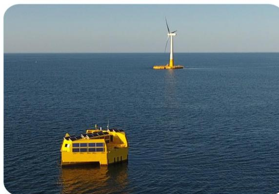
**La proximité de la livraison** est un élément clé de la réussite du projet, du fait des coûts de transport élevés de l'hydrogène en petites quantités. L'idée du démonstrateur est de tester le comportement du premier électrolyseur au monde qui fonctionnera en pleine mer, avec un minimum rentable à 300 MW de production d'hydrogène.
