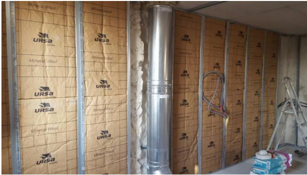
Figure 1 Pose de laine de roche (ITI)
