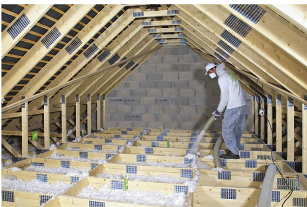
Figure 3 Caissons bois à remplir d'isolant en combles (PSE insufflé)
