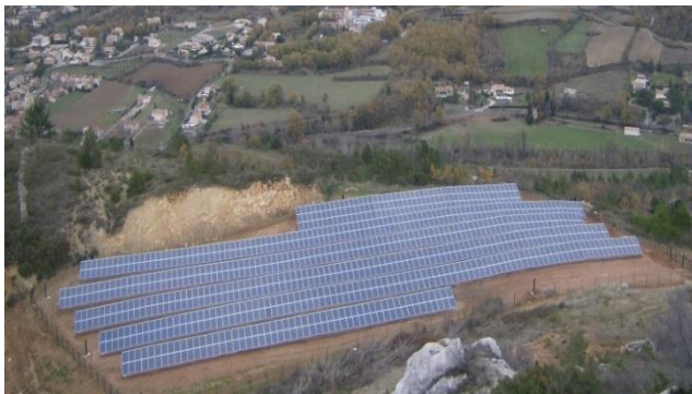
Figure 3 parc solaire de Roquefumade (Aude) de Soleil du Midi
