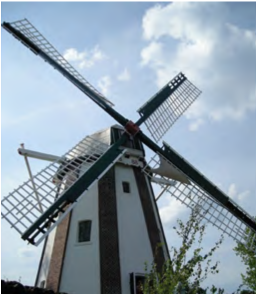
Moulin à vent du XIX e siècle dans le nord de l'Allemagne. Noter le vrillage des pales du rotor.
