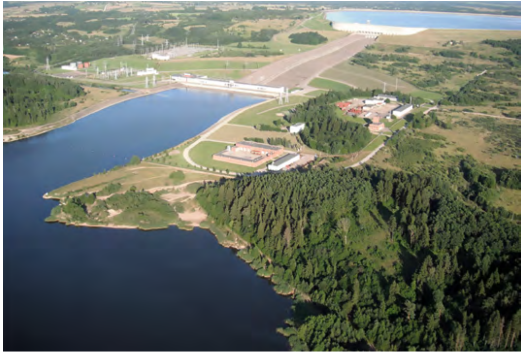
Centrale de pompage-turbinage (STEP) de Kruonis en Lituanie,
