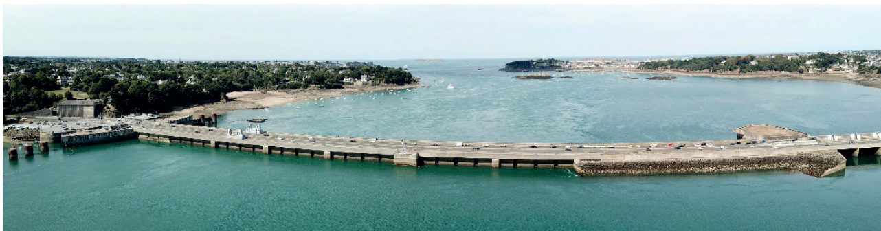
Figure 3 : Usine marémotrice de La Rance (240 MW), mise en service en 1966 sur l'estuaire de La Rance entre Dinard (à gauche) et Saint-Malo (à droite) – Crédit photo : Bernard Multon
