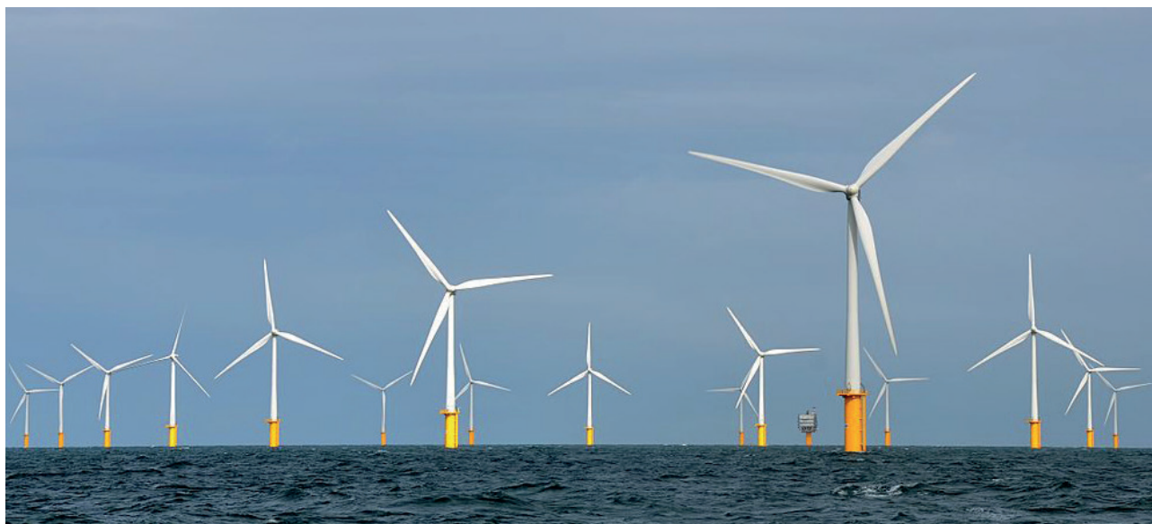
Figure 4: Parc éolien posé de Belwind 1 (55 éoliennes de 3 MW) situé à 47 km au large de Zeebrugge (Belgique) Crédit photo: Hans Hillewaert, Wikipedia
